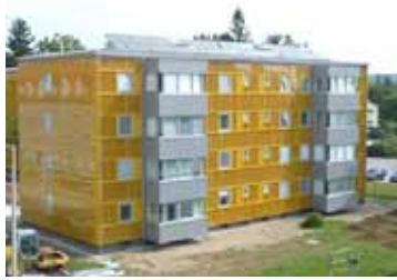
Sanierung Graz, Dieselweg 4-8, 54 WE
