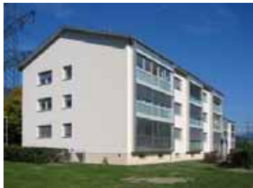
Sanierung Nenzing/Vlbg., 18 WE
