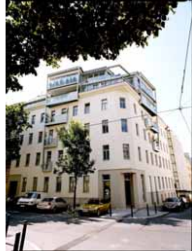
Sanierung Wien 15, Märzstraße, 23 WE
