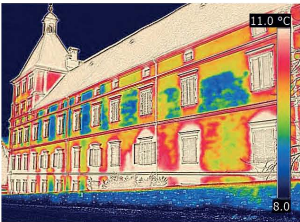
118. Graz, Steiermark, Schloss Eggenberg, Wärmestrahlungsbild der Nordfassade; die unterschiedlichen Oberflächentemperaturen erlauben nicht nur Rückschlüsse auf ehemalige Gebäudehöhen, zwischen der 4. und 5. am Bild sichtbaren Fensterachse von rechts zeichnet sich im 2. OG wohl auch eine Außenkante des Vorgängergebäudes ab
