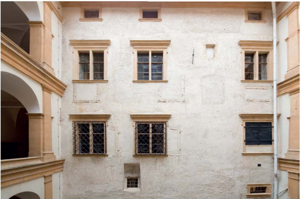
117. Graz, Steiermark, Schloss Eggenberg, freigelegte Fassade des Vorgängerbaues im nördlichen Nebenhof
