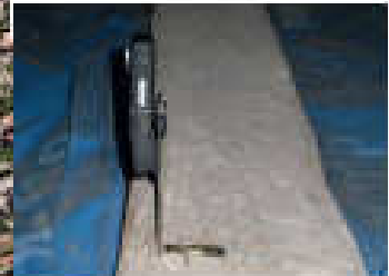
Position Datenlogger ca. 0,5m über Boden
