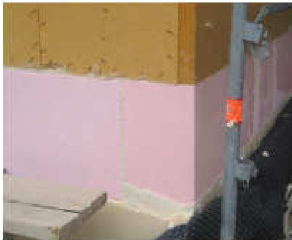
Außenseite wird verputzt
