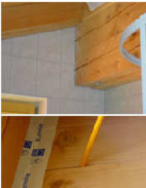
Undichtheiten durch Risse im Holz
