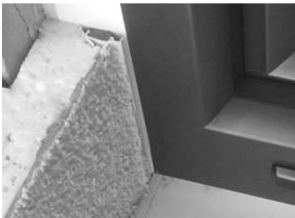
Abbildung 20: Fenster mit Vorsatzschale als Halbschale ausgeführt
