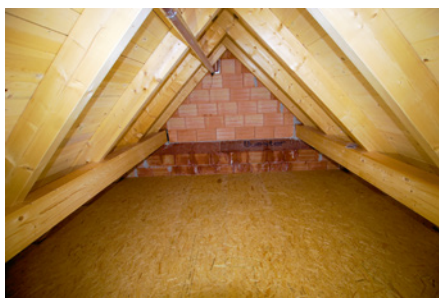
2, 3, 4 | Bei Reihenhäusern, die 2018 fertiggestellt und bezogen wurden, bildeten sich im ersten Winter punktuell Nässe und Schimmel an der Baukonstruktion. Bild 2 (links) zeigt die Problemstellen an der Dachschräge über dem Bad, die Bilder 3 (Mitte) und 4 (rechts) an der Giebelwand zwischen Zangendecke und Betonkranz sowie an der Dachschalung, anschließend an die Giebelwand bis unter den Giebel.
