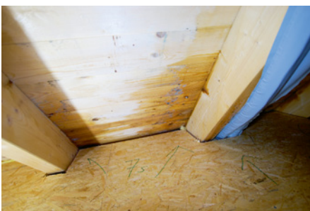
2, 3, 4 | Bei Reihenhäusern, die 2018 fertiggestellt und bezogen wurden, bildeten sich im ersten Winter punktuell Nässe und Schimmel an der Baukonstruktion. Bild 2 (links) zeigt die Problemstellen an der Dachschräge über dem Bad, die Bilder 3 (Mitte) und 4 (rechts) an der Giebelwand zwischen Zangendecke und Betonkranz sowie an der Dachschalung, anschließend an die Giebelwand bis unter den Giebel.
