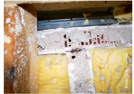
9, 10, 11 | Bauteilöffnung vor Ort – Stunde der Wahrheit: Die Öffnung der OSB-Platten an den thermografisch auffälligsten Stellen zeigte starke Schimmel- und Kondenswasserbildung an der Plattenunterseite (Bild 9 links). Die Zangen waren oben schon durchnässt (Bild 10 Mitte). Die eigentliche Ursache lag am teils fehlenden Mauerkronenverschluss der Zwischenwände (Bild 11 rechts).
