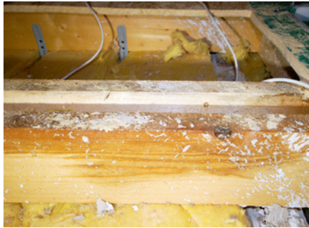
9, 10, 11 | Bauteilöffnung vor Ort – Stunde der Wahrheit: Die Öffnung der OSB-Platten an den thermografisch auffälligsten Stellen zeigte starke Schimmel- und Kondenswasserbildung an der Plattenunterseite (Bild 9 links). Die Zangen waren oben schon durchnässt (Bild 10 Mitte). Die eigentliche Ursache lag am teils fehlenden Mauerkronenverschluss der Zwischenwände (Bild 11 rechts).
