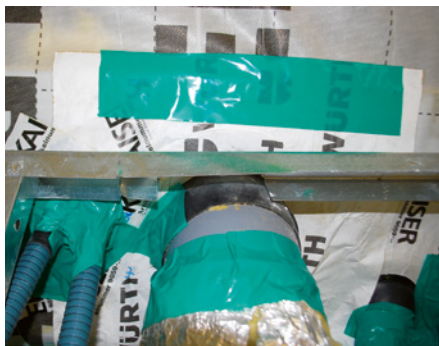
12 | Im Bad waren an den Leitungsdurchführungen markante Undichtheiten vorhanden. Das lag an schlampigen Verklebungen, zu knapp beieinander liegenden Leitungen und mangelndem Platz für die Manschetten.
