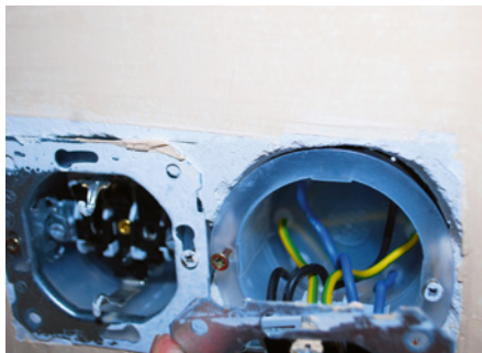
13 | Leckageweg von der Dreifachsteckdose an der Außenwand zum Spitzboden verursacht Nässe an der Dachschalung der Giebelwand: Es gab zwar luftdichte Einsätze bei den Steckdosen, aber ein Luftspalt zwischen diesen und dem Mauerwerk machte die Unterputzdose in Summe undicht.
