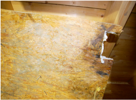
9, 10, 11 | Bauteilöffnung vor Ort – Stunde der Wahrheit: Die Öffnung der OSB-Platten an den thermografisch auffälligsten Stellen zeigte starke Schimmel- und Kondenswasserbildung an der Plattenunterseite (Bild 9 links). Die Zangen waren oben schon durchnässt (Bild 10 Mitte). Die eigentliche Ursache lag am teils fehlenden Mauerkronenverschluss der Zwischenwände (Bild 11 rechts).
