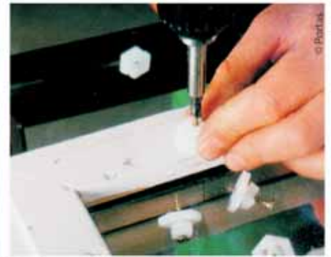
Fenster und Türen auf Undichtheiten prüfen
