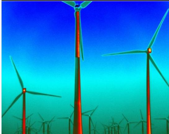
**Bild 2: Windkraftpark bei Gols, verschiedene Gondelkonstruktionen führen zu unterschiedlichen Temperaturen am Generator**
