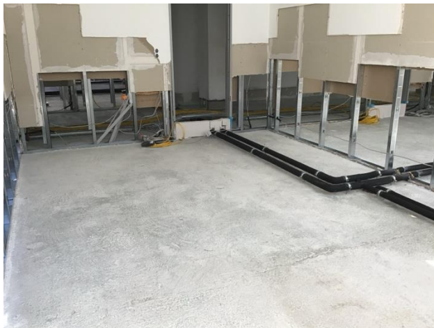
Bild 4: Rückbau und Feinreinigung
