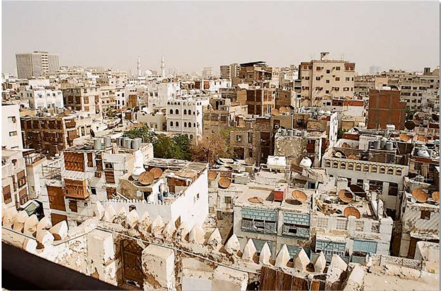
Al Balad, historische Altstadt von Jeddah, an der Küste des Roten Meeres in Saudi Arabien (Quelle: TU Wien, 2011)
