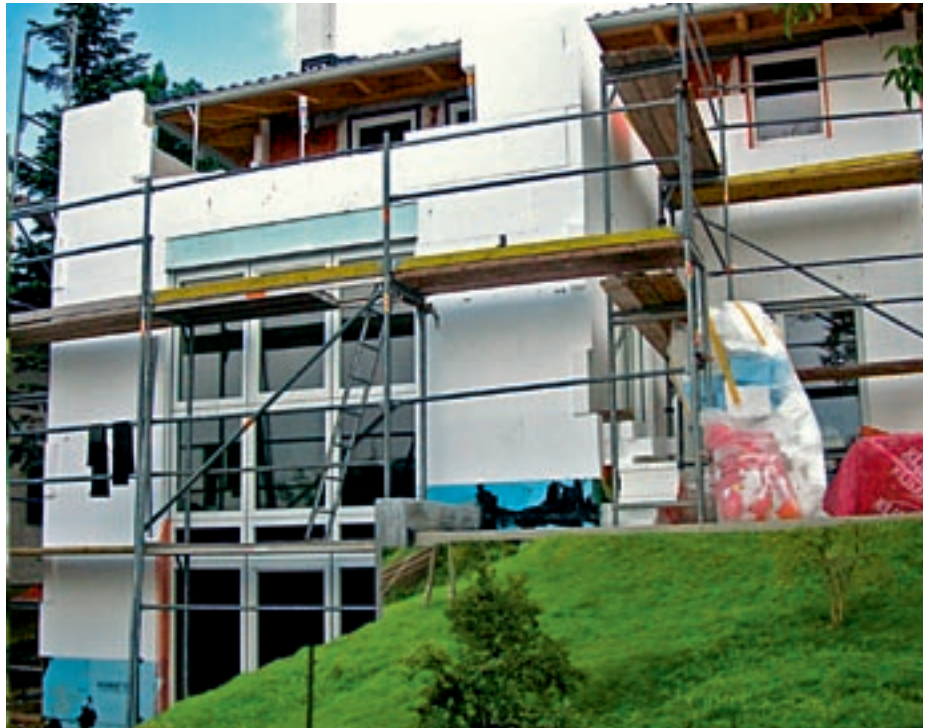
Wärmebrücken treten oft bei Fensteranschlüssen, Traufpunkten und Sockelbereichen auf
