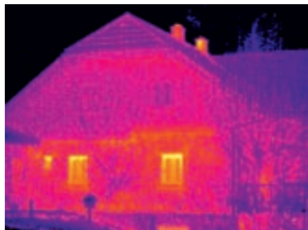
Ungenügende Außenaufnahmen denn ...
