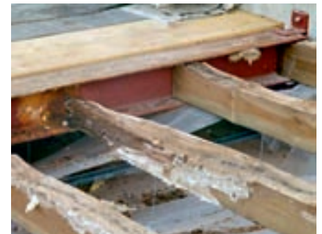
Bauschäden Das war einmal ein Flachdach
