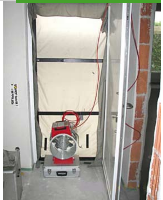
Blower Door in Haustüre montiert.
