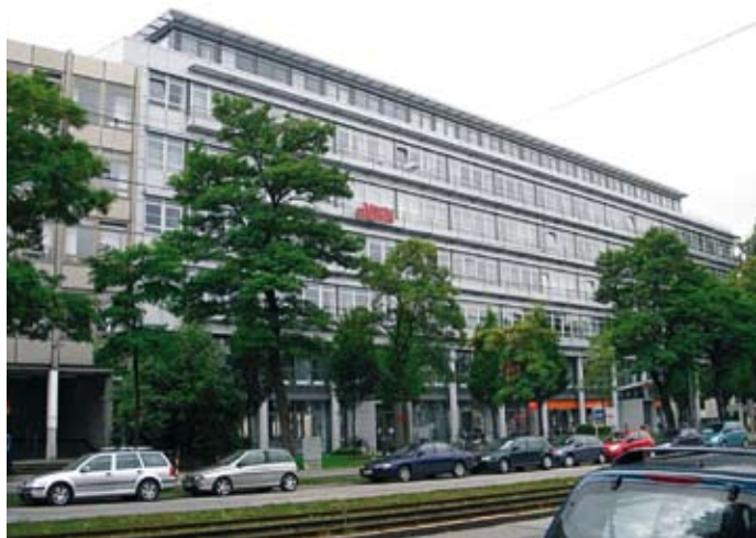
Verwaltungsgebäude mit ca. 9.600 m 2 Nutzfläche.
